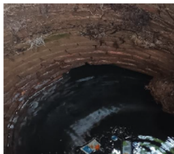
Pozo 2 llegamos de nuevo a nivel de conducto entre pozos
