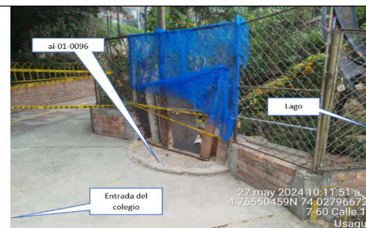
Foto No. 4. Ubicación del aljibe aj-01-0096
