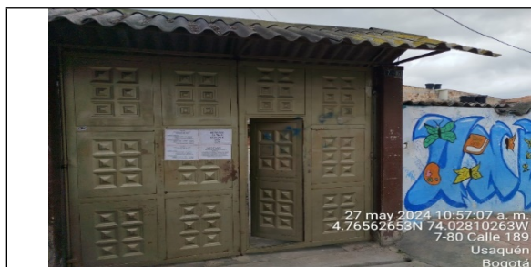
Foto No. 1. Vista general de entrada al predio
