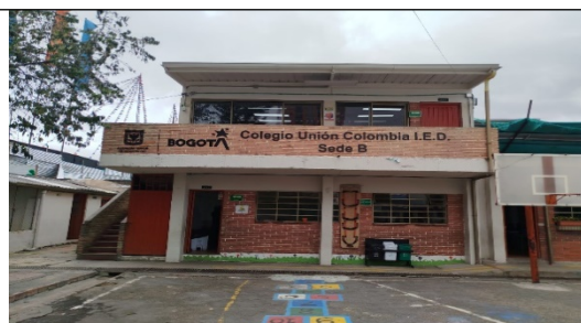
Foto No. 2. Vista del colegio al interior del predio
