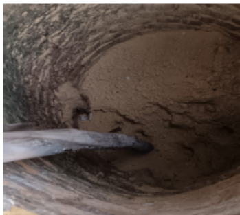
Compactación de material
