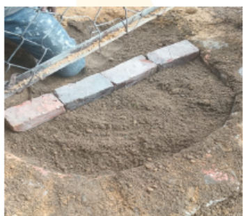
Adecuación de terreno
