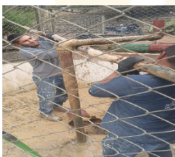
Retiro de tubería en aljibes 2
