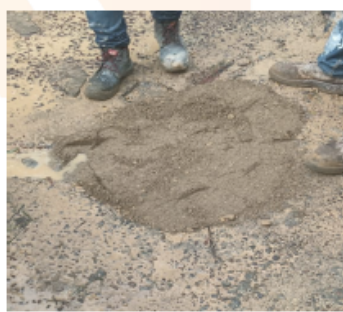
Taponamiento de aljibe 2
