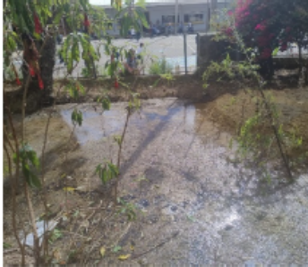
Se evidencia brote de agua en terreno adyacente a los aljibes
