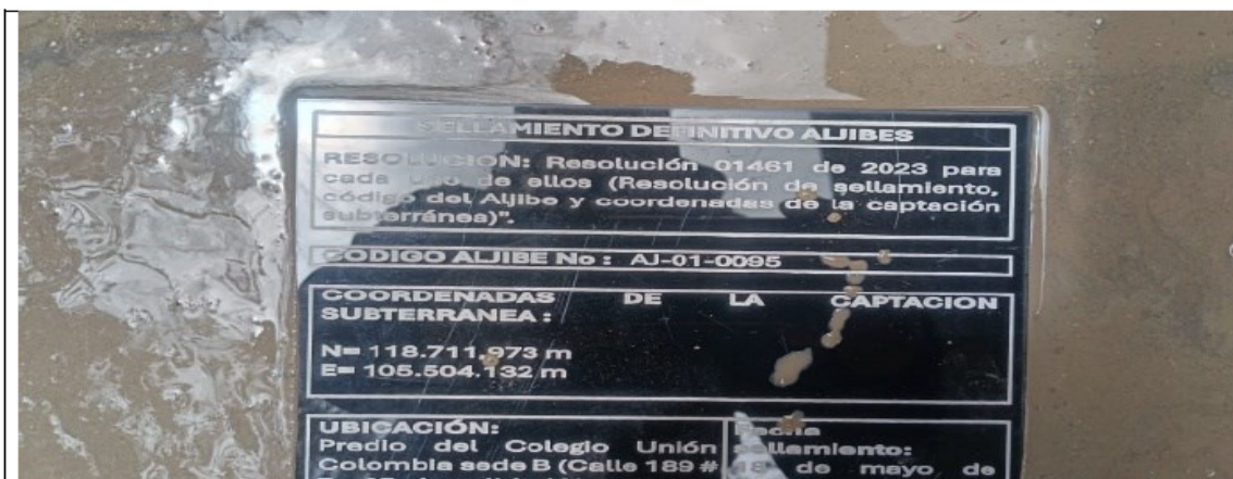
Aljibe AJ-01-0095 Sellado, acabado en concreto y placa instalada
