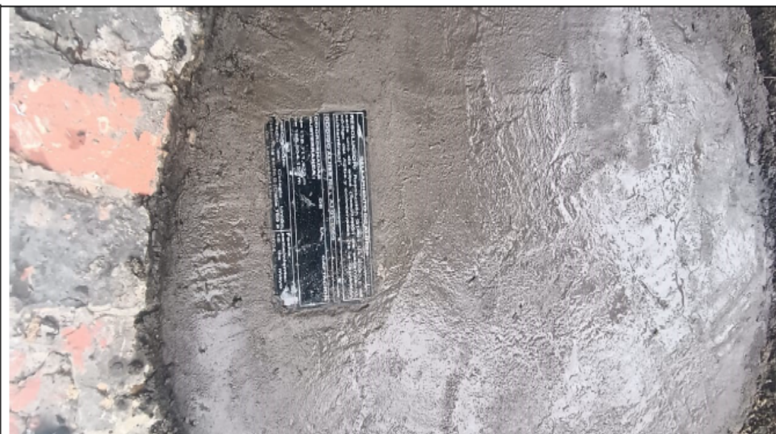
Aljibe AJ-01-0096 Sellado, acabado en concreto y placa instalada
