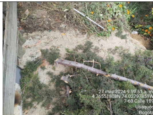
Foto No. 9. Relleno del aljibe con arena de río y recebo
