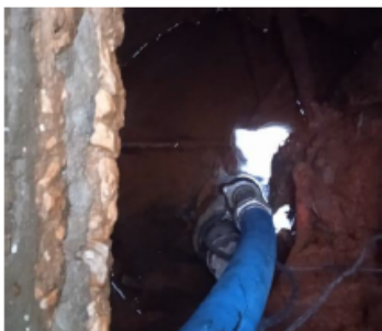
Se desocupa totalmente los pozos
